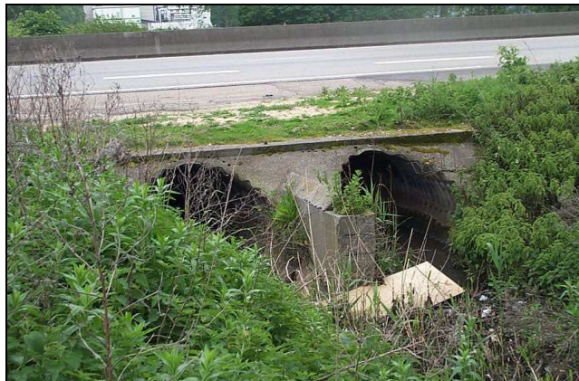
Vue sur ouvrage de rétablissement A131 – Cote de l'estuaire
