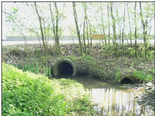
Vue sur ouvrage de rétablissement A131 – Pissotière à Madame
